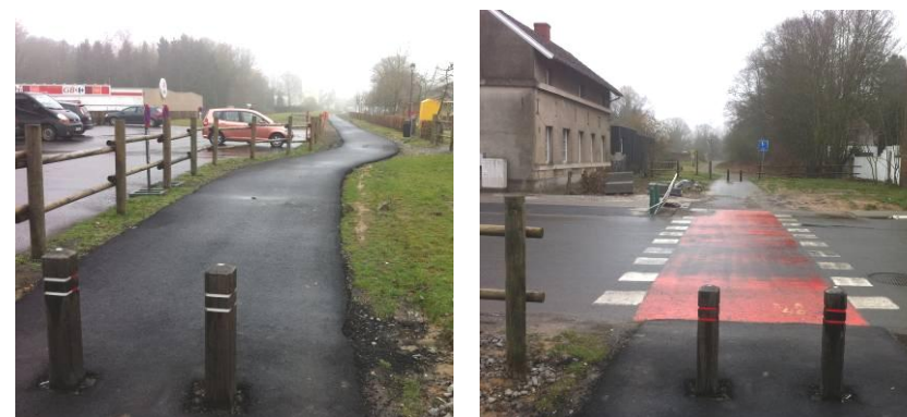
RAVeL : traversée de la rue de Charleroi
